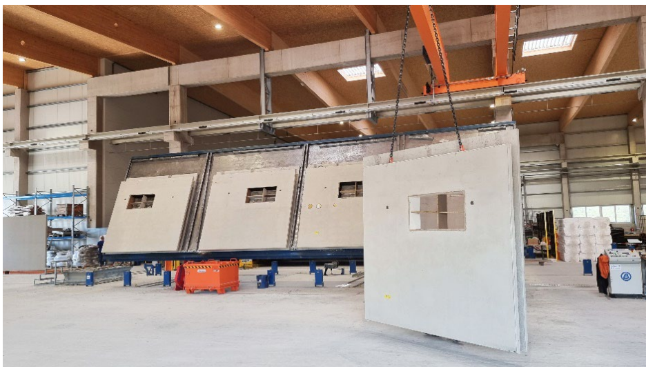
Фото 9: Вертикальный подъем двойных стен выполняется с помощью опрокидывающей станции Vario TILT.
