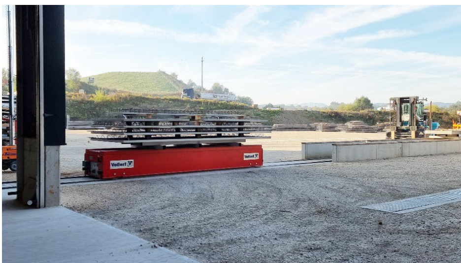
Фото 10: Для транспортировки штабелей элементов сборных перекрытий наружу используется вывозная тележка.
