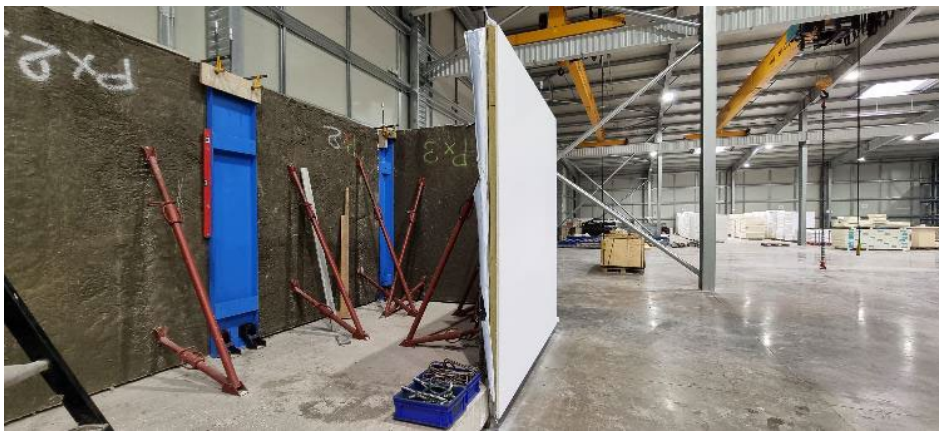
Figura 10: Todos os módulos individuais de um andar do edifício são pré-montados e harmonizados entre si. Isto garante uma montagem sem problemas no local de construção.
