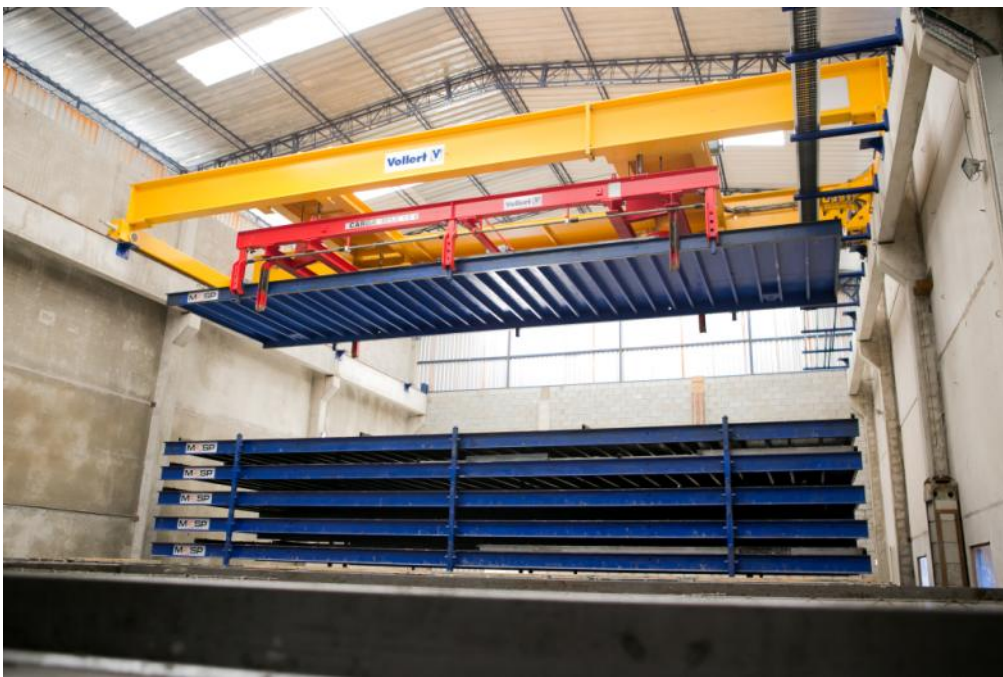
Fig. 4: 运用现代化固化工艺，大大缩短凝固和脱模之间的转换时间
