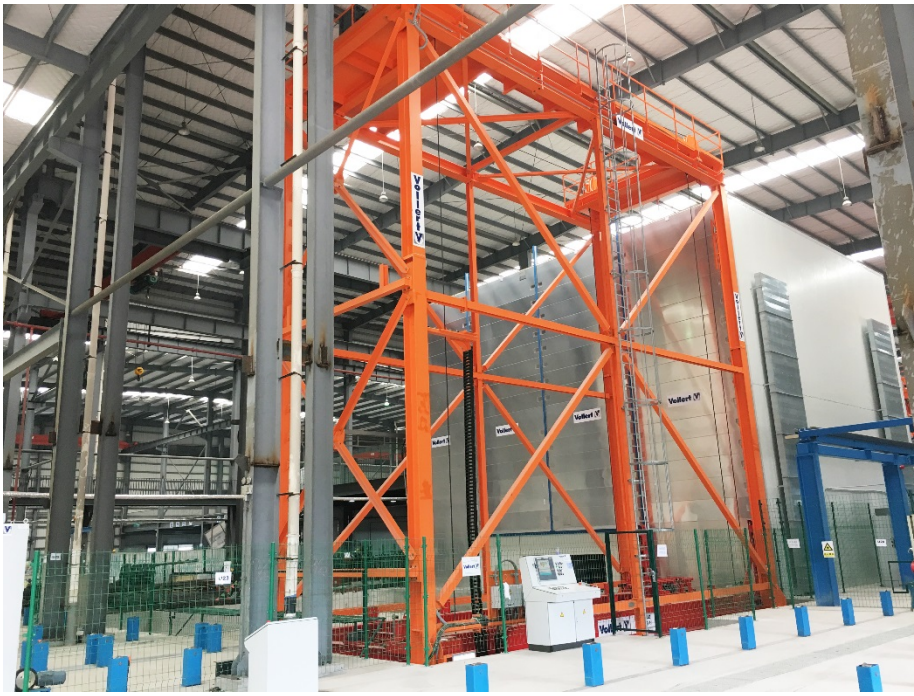
通过Vario Store 存储和检索机来操控养护箱的绝缘和加热架塔
