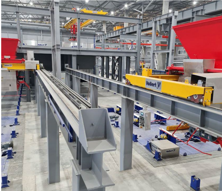
Figura 6 Duas linhas de concretagem paralelas com distribuidores automáticos de concreto SMART CAST garantem tempos de ciclo de concreto ideais e dosagem precisa de concreto.
