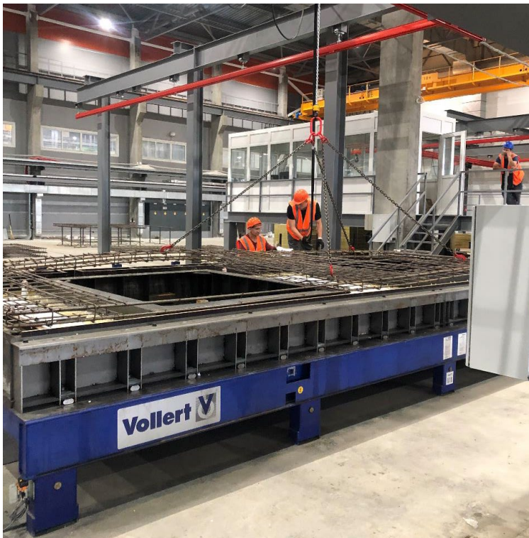
Figura 7 As vigas especiais de manuseio da Demag são usadas para transportar o sistema de desmoldagem e as esteiras de reforço entre as linhas individuais e as estações de trabalho.
