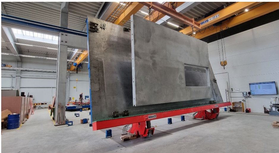
Figura 11: La elevación vertical de las paredes se realiza mediante una estación basculante de alto rendimiento VARIO TILT.
