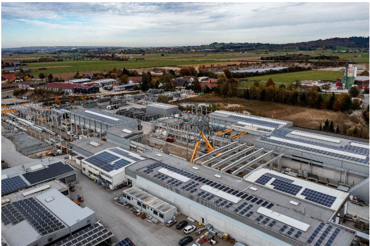
Figura 1 - 3: La nueva planta de producción de muros macizos y sándwiches de UNGLEHRT en Bad Grönenbach se construyó en una planta y un edificio ya existentes.
