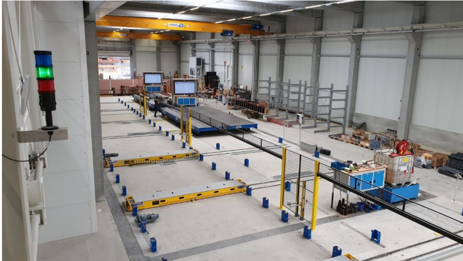
Figura 4: Para las actividades que requieren mucho tiempo, como los trabajos de encofrado y refuerzo, se instalaron estaciones de descarga independientes del tiempo de ciclo.
