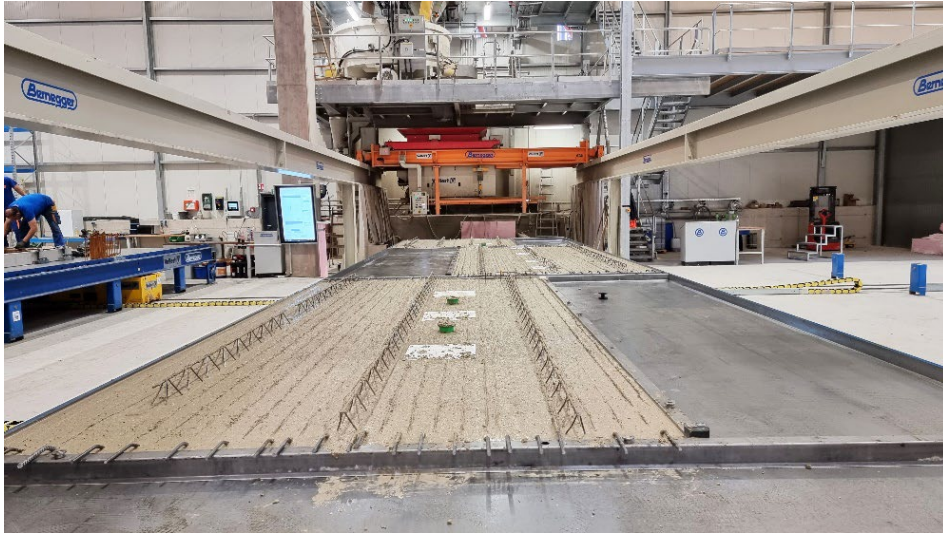
Figura 5: Una distribuidora de hormigón SMART CAST totalmente automática y guiada por puentes con tecnología Tough Cast garantiza un proceso de hormigonado óptimo en Bernegger.
