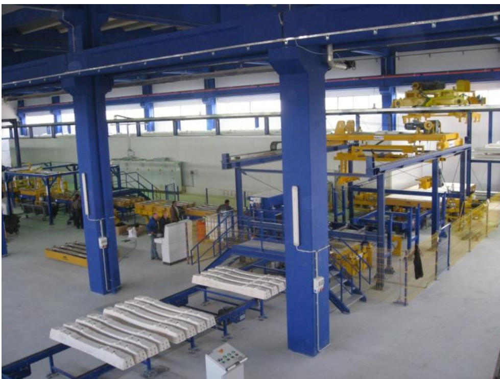
Fig 8: Transfert des traverses démoulées à la station de montage des appuis pour les rails
