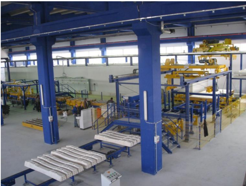
Fig 8: Os dormentes são enviados para montagem final
